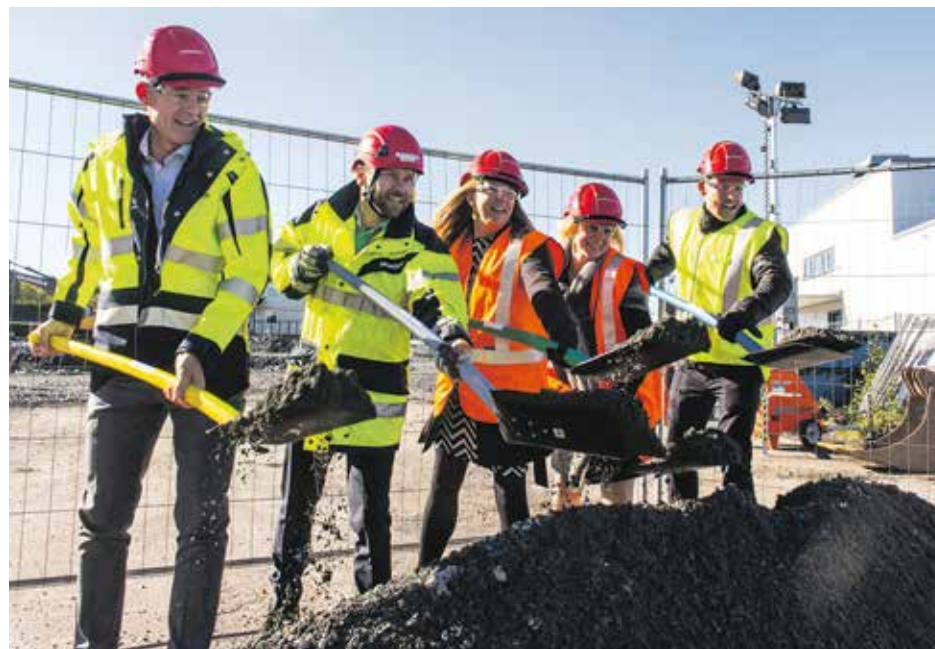
Äntligen. Ale kommun och Skanska tog i måndags ett första spadtag för ett nytt centralt äldreboende i Älvängen. Platsen är bakom Coop, där den gula villan tidigare låg på Göteborgsvägen.
